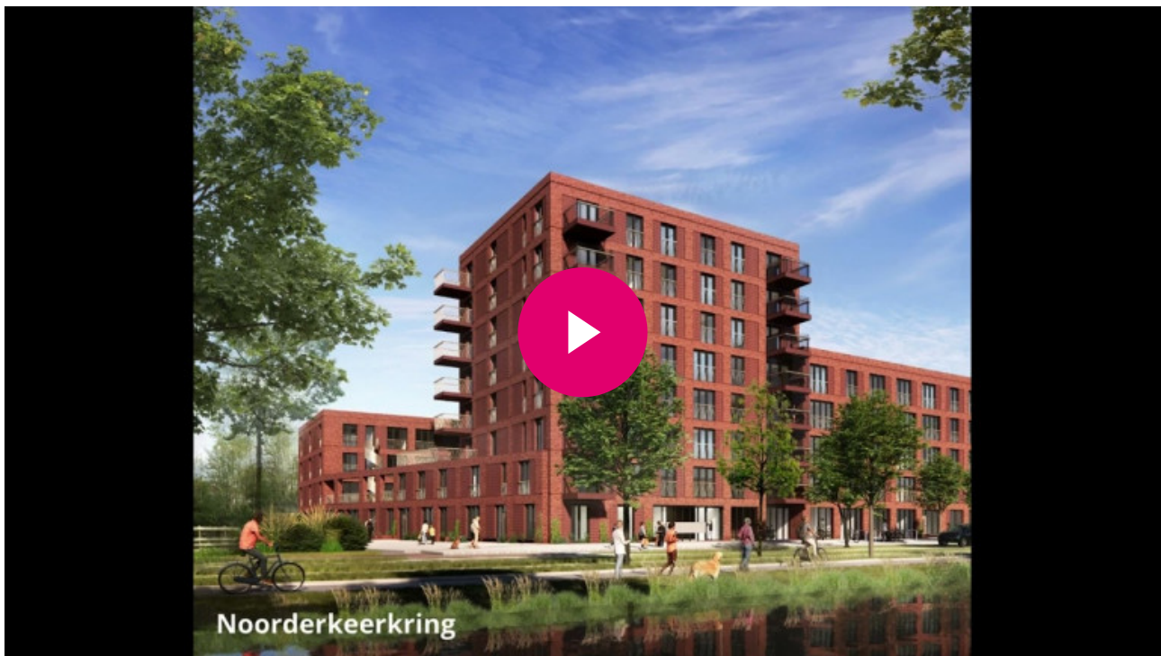
Onze nieuwbouw in voorbereiding en uitvoering
